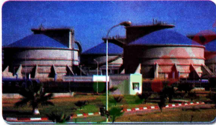
محطة تحلية مياه البحر بالمقطع، وهران
