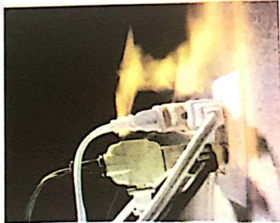
3 - استخدام غير سليم لمأخذ الكهرباء في المنزل!
