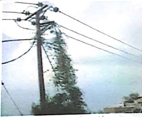
2 - الشجرة تلامس أسلاك الشبكة الكهربائية
